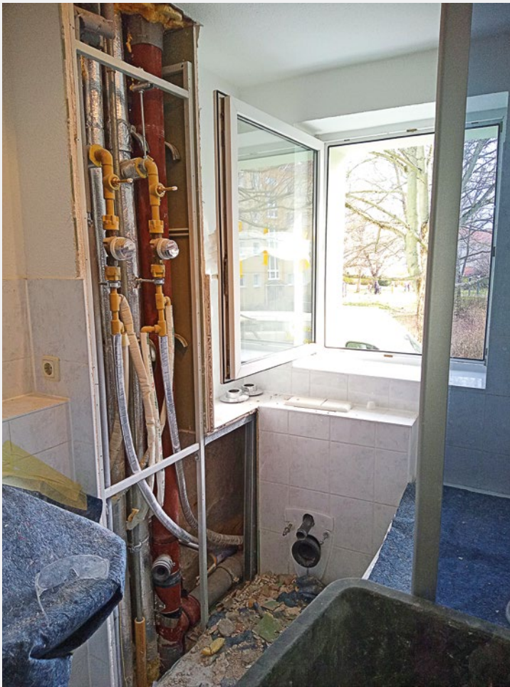
Fertiggestellte Installation kurz vor dem Verschluss des Installationsschachtes
