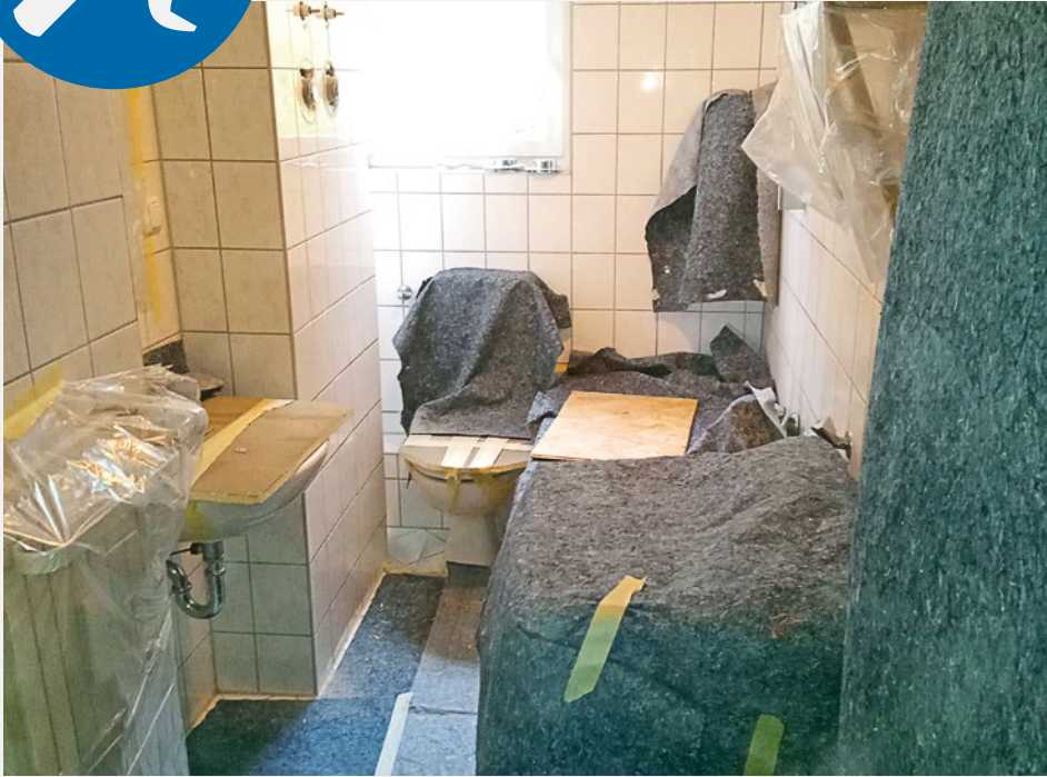
Abklebarbeiten im Bad – Alles gut verpackt – jetzt kann es losgehen
