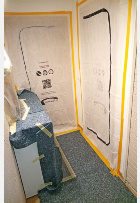
Abklebarbeiten im Flur mit Staubschutztüren
